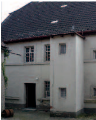
Vorzustand der Hoffassade
