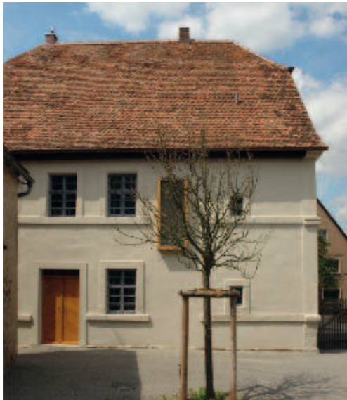
Die hofseitige Fassade nach Abbruch eines neuen Anbaus
