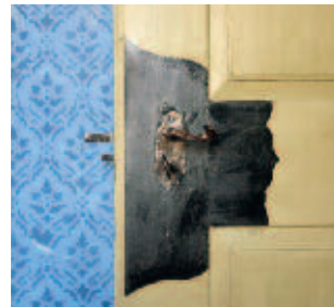
Türbeschlag im ersten Obergeschoss
