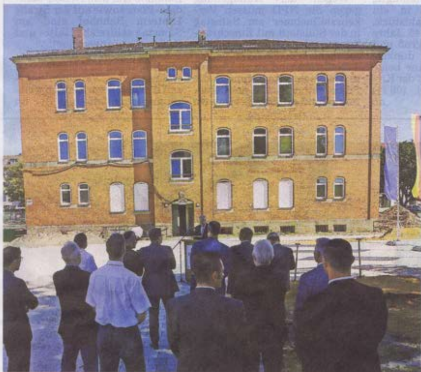
Das ehemalige Kasernengebäude muss saniert werden. Foto: Roland Fengler
